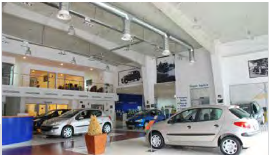
attraktive Innenansicht der Tragkonstruktion, keine Verkleidung erforderlich
